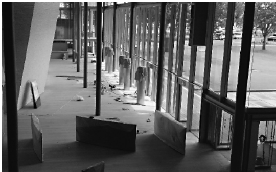
一部供用が開始したアールの工事状況
