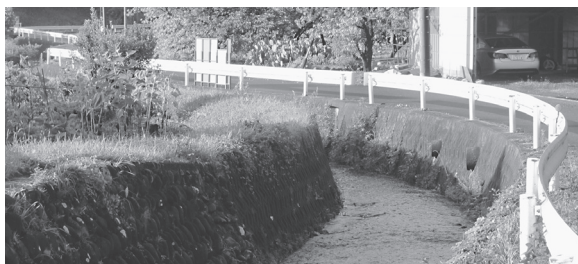
石原川オーバーフロー防止工事着工前
