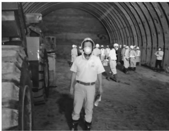
市道56号二野・大森線トンネル工事現場視察
