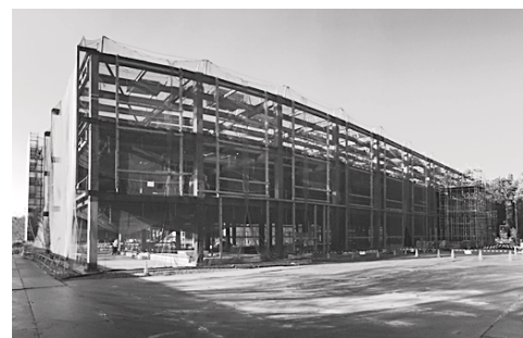
工事順調！岐阜医療科学大学薬学部棟
